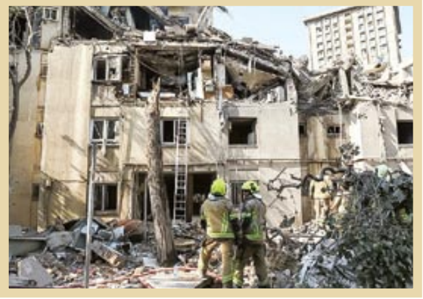
در خدایدان باترس لوبوسوا ۳۳ خرداد ۱۴۰۴ تهران، تلفات ناشی از حمله رژیم صهیونیستی به ساختمان
