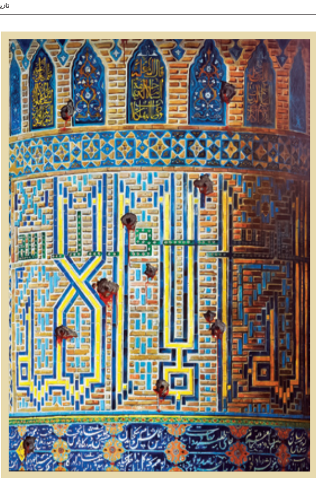
طرحی از دیوار تیر خورده مسجد گوهرشاد آستان قدس رضوی(ع)
