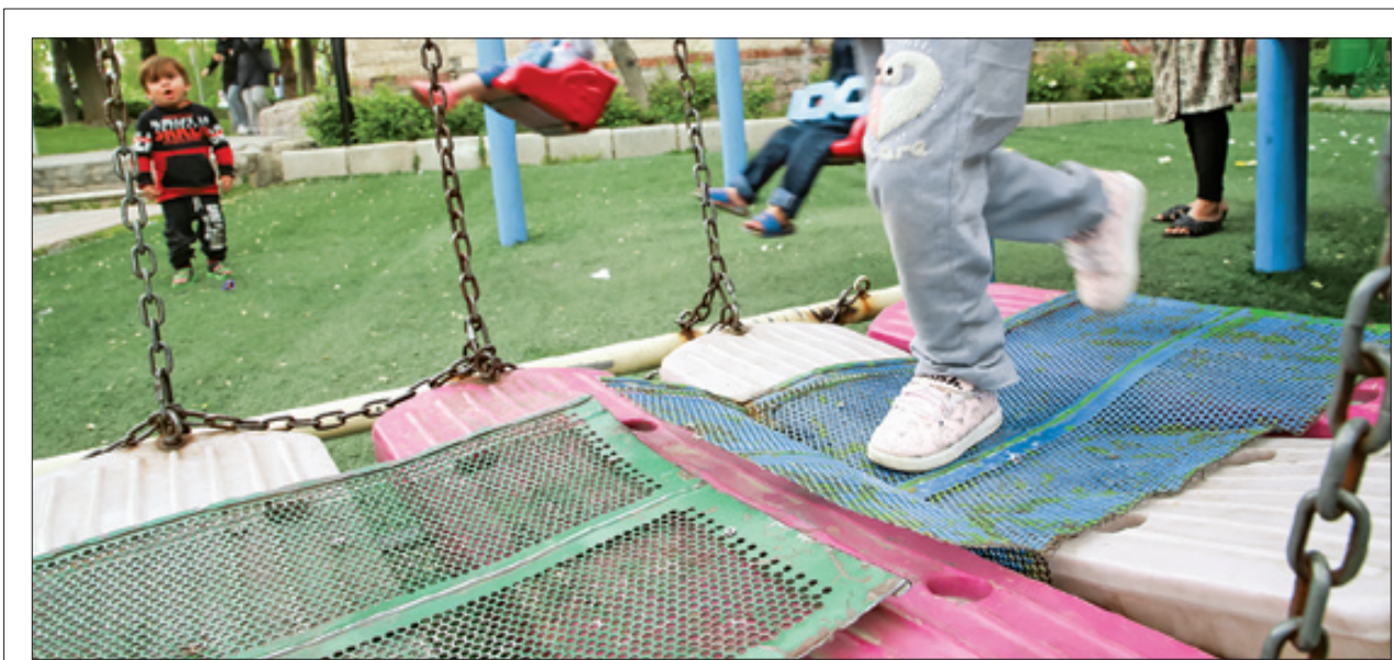
کفپوش فلزی در محل بازی کودکان خمیده و شکسته شده که برای آنها خطر آفرین است
