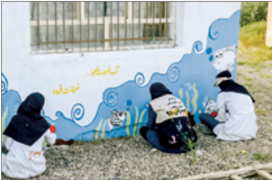
رنگ آمیزی و بازسازی مدارس
