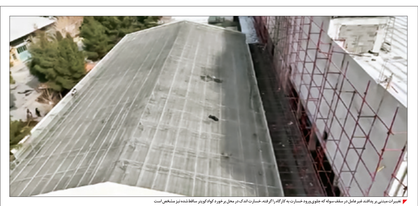
تغییرات مبتنی بر پدافند غیرعامل در سقف سوله که جلوی ورود خسارت به کارگاه را گرفته. خسارت اندک در محل بر خورد کواد کوپتر ساقط‌شده نیز مشخص است
